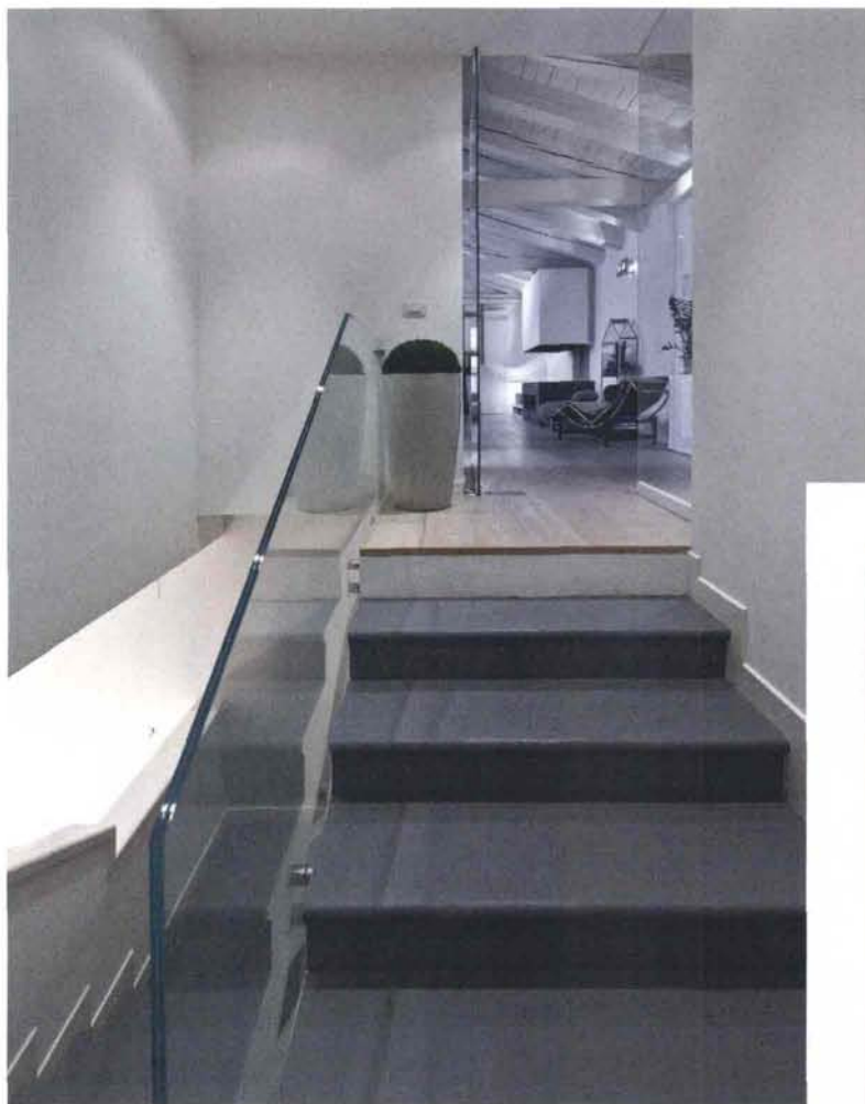
La scala, è stata dipinta con una miscela di vernici stradali particolarmente resistenti all'usura.
